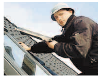
25 000 € offen: Dachdecker Bernd Schröter, 49, verlegte Ziegel auf sechs Dächern
