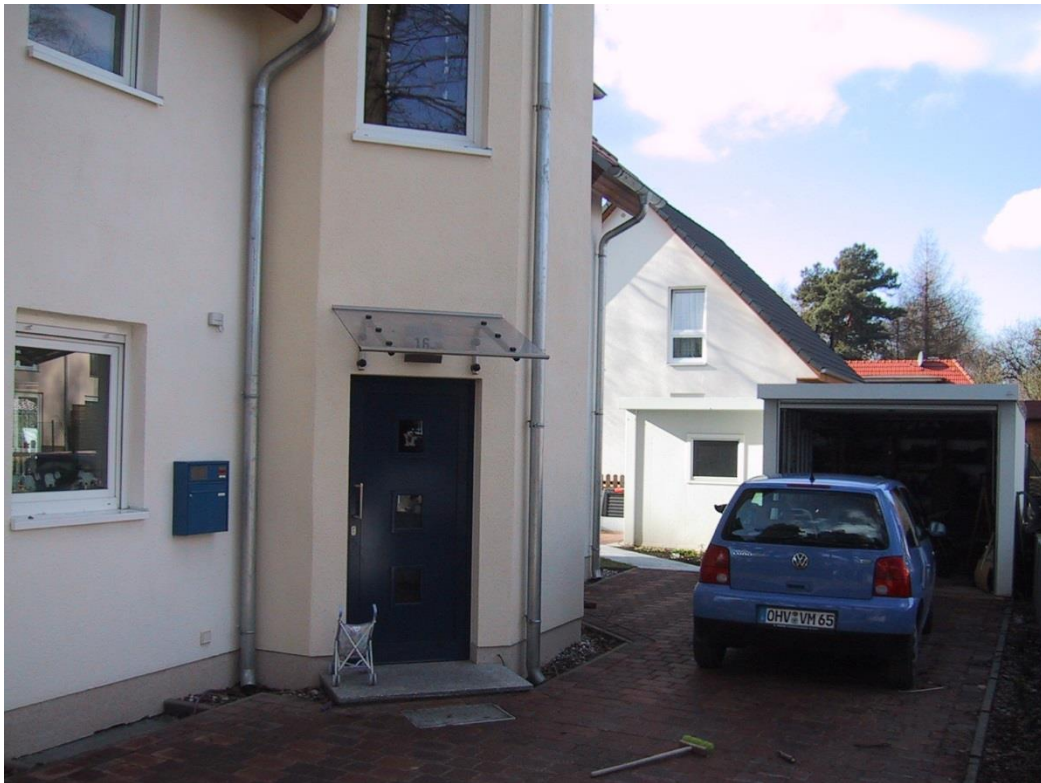
Bild 9: Nordseite mit Garage und Stellplatz (2004)
